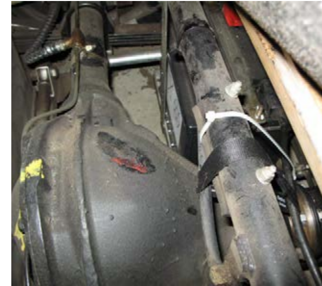
Massekabel von links (Rahmen) nach rechts verlegt
